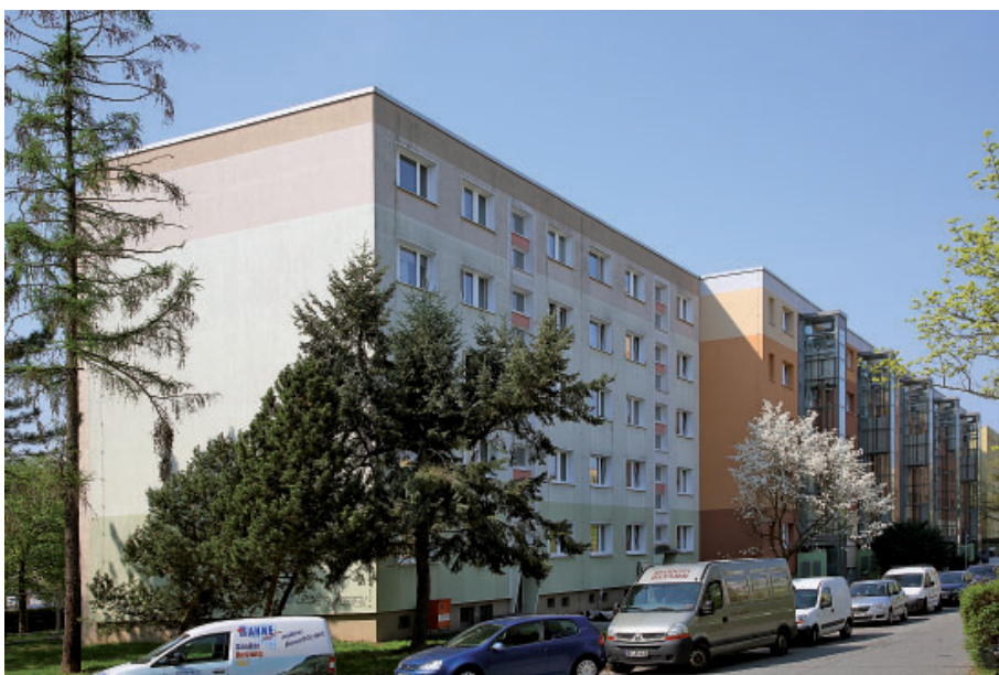
Mit der Modernisierung und dem Anbau von Aufzügen in der F.-Wolf-Straße 13–15 (vorn links) wird das Gesamtvorhaben an diesem Wohnblock abgeschlossen.
